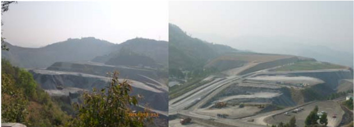
图 4-10 废渣坝坝顶上大量弃渣堆积
