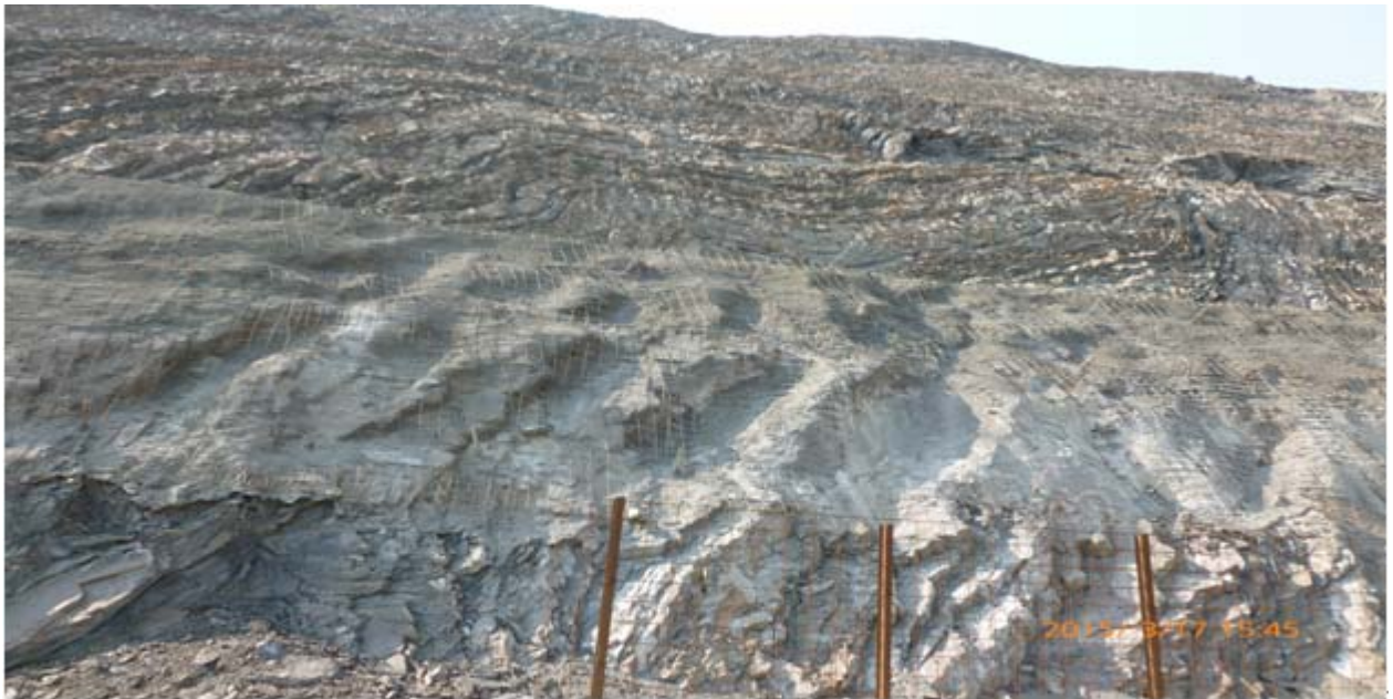
..... 图片 4-6 露天边坡挂网喷浆支护
