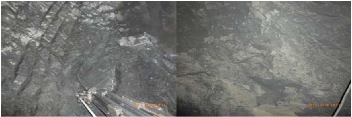
图片 1-1 示赋存于 F_2 断层下盘的 ③号矿体。图片右面为 F_2 破碎带，含矿岩性为发育破劈理的薄至中厚层砂岩夹粘土岩。11 线 360m 标高。
