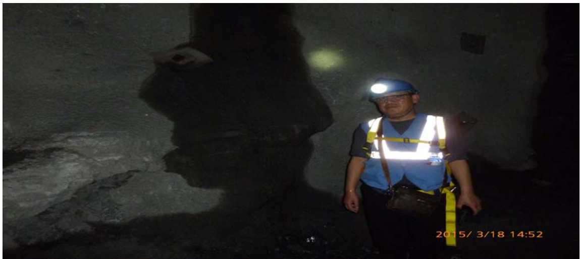
图片 4-1 15 勘探线 270m 水平巷道浸水点已灌浆进行封堵
