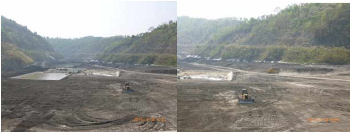
图片 4-15 炭浸尾矿库及尾水处理设施
